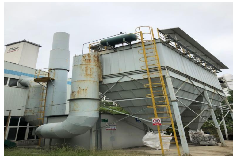
附图 4-项目现场照片
